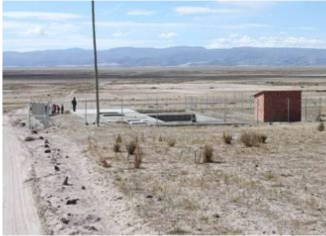
Foto: Planta de Tratamiento de Aguas Residuales del Municipio Santuario de Quillacas
