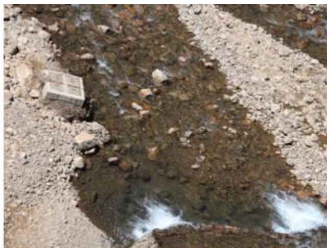
Foto: La comisión visitó la galería filtrante de 80 m. de longitud, ubicada en el río Uyuchama, con un caudal 17 l/s, en funcionamiento desde agosto del 2010. La obra fue construida porque en la época de estiaje baja considerablemente el caudal de agua y no alcanza la dotación requerida.
