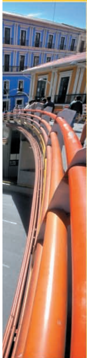
Pasarela de la Pérez Velasco
