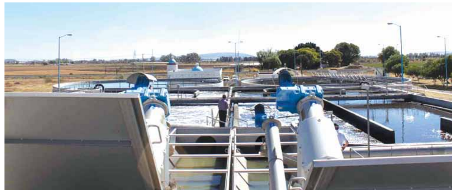
▲ Nueva planta de tratamiento de aguas residuales con tecnología de lodos activados JAPAMI (Irapuato-México), misma que fuera visitada por la delegación boliviana.
