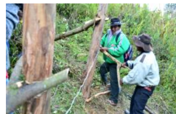
Finalmente: cerramiento completo del ANSA
