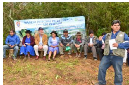
En la foto: diversas autoridades locales e invitados de la Cooperación Sueca y Alemana, dieron inicio a las obras de protección de las fuentes de agua.
