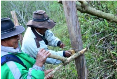
Comunarios de la zona de Viscachani, realizan el tendido de alambre de púas, que protegerá el área, contra el ingreso de animales a la fuente.
