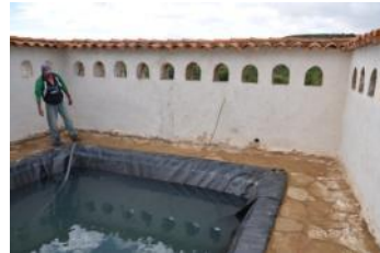
Reservorio en el que se almacena el agua que proviene del manantial protegido
