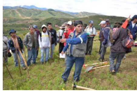
En la foto: el ingeniero Ignacio Guzmán, organiza los grupos de trabajo para dar inicio a las obras de protección de las ANSAs.
