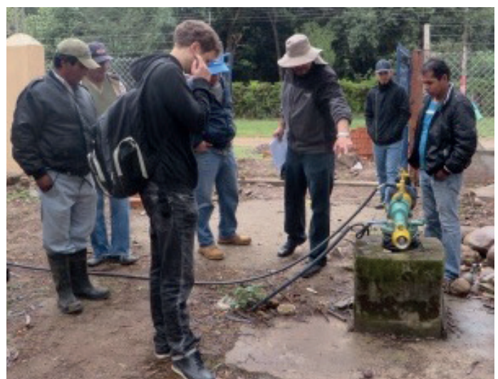
Inspección Sanitaria a pozo en Porongo. Fuente: elaboración propia.
