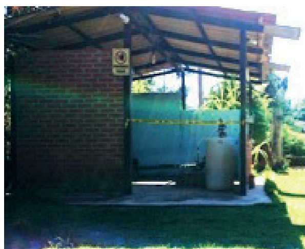
Caseta de pozo después de la Inspección Sanitaria. Fuente: elaboración propia.
